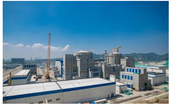
厂区 5/6 号机组全景
