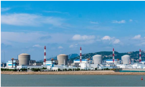
厂区 1-4 号机组全景
